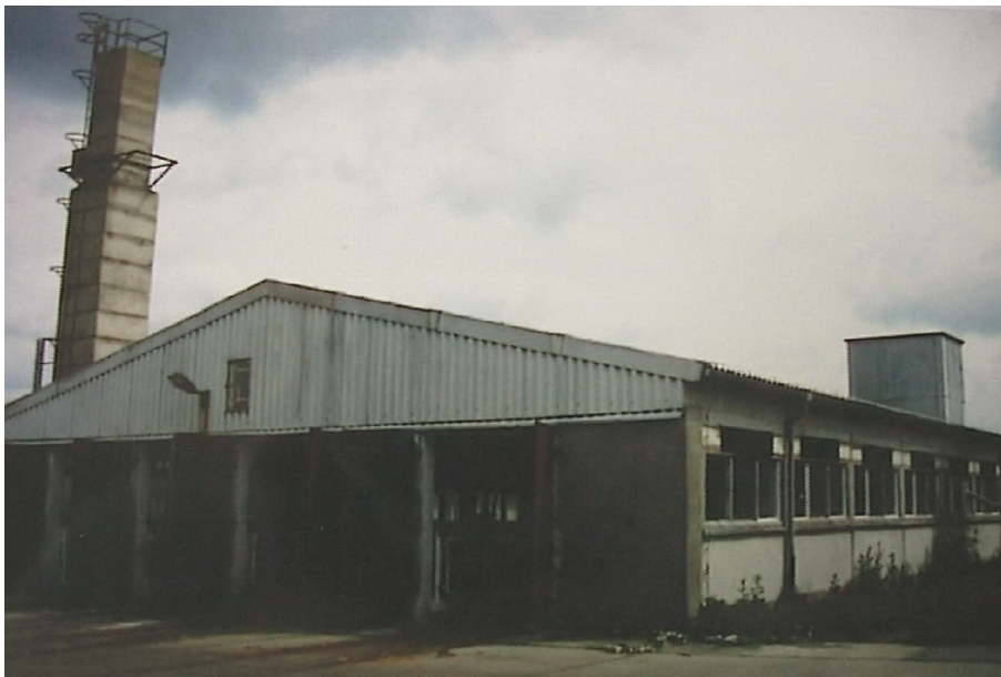
Abbildung 26: Südwestansicht eines Offenstalles mit Schwerkraftlüftung mit einem dachmitten platzierten Abluftschacht in Faulenhorst (Sachsen-Anhalt). Jeweils vier Tore auf beiden Giebelseiten sind geöffnet, die Fenster an den Seitenwänden sind geschlossen. Der Stallinnenraum besitzt eine geschlossene Zwischendecke in Traufhöhe.
