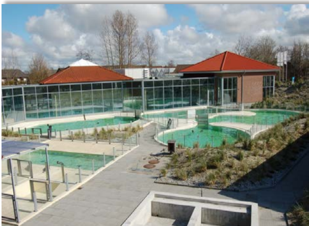
Abbildung 2.3-14: Übersicht der Beckenanlage
