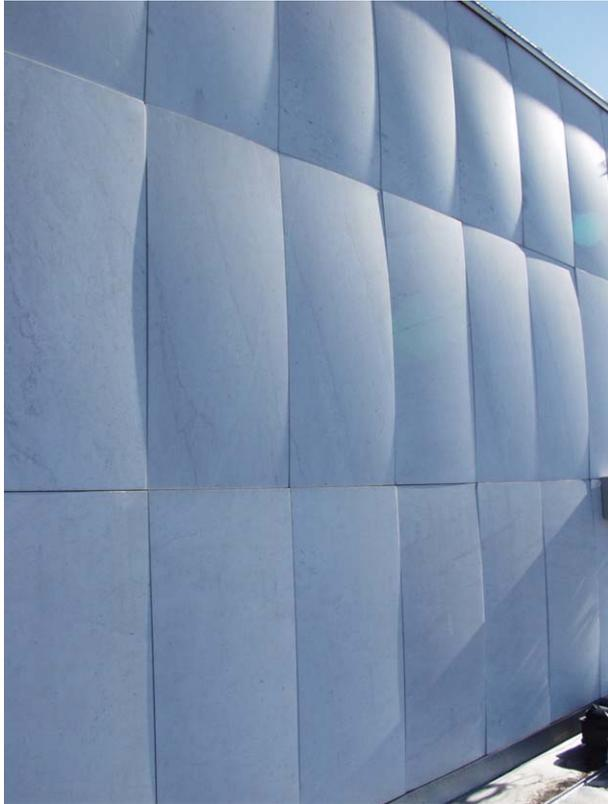
Abb. 7.1: Mehrheitlich konvex verbogene Fassadenplatten aus Marmor an der Staats- und Universitätsbibliothek in Göttingen. Die Deformation von Fassadenelementen stellt ein wesentliches Schadensphänomen dar, dass einige Marmortypen bereits kurz nach ihrer Anwendung im Außenbereich aufzeigen können (aus Koch 2005).
