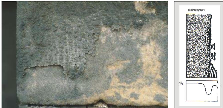
Abb. 7.4: Verwitterung von Sandstein durch Krustenbildung. Schaden am Bauwerk (links, aus Fitzner & Heinrichs, 2004) und Verteilung der Zugfestigkeiten  $\beta_z$  im Gestein (rechts, aus Hörenbaum 2005).
