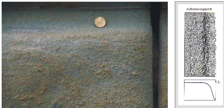
Abb. 7.2: Verwitterung von Sandstein durch Absanden. Schaden am Bauwerk (links, aus Fitzner & Heinrichs, 2004) und Verteilung der Zugfestigkeiten  $\beta_z$  im Gestein (rechts, aus Hörenbaum 2005).
