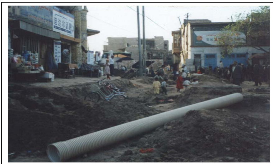
Abbildung 5: Errichtung von Abwasserleitungen in Kashgar
