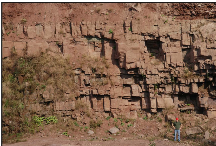
Abb. 3.7.: Sandsteinbänke der Karlshafener Schichten im aktiven Steinbruch „Dreiländereck“. Das Gestein ist stark zerklüftet und keilt aufgrund der fluviatilen Ablagerungsbedingungen häufig innerhalb von mehreren Metern aus (Blickrichtung nach Norden).
