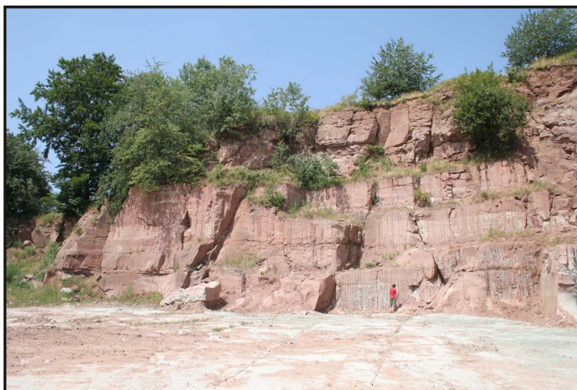
Abb. 3.11.: Aktiver Steinbruch in Uder, in dem der Solling-Bausandstein aufgeschlossen ist. Die Schichten sind der Region entsprechend äußerst dickbankig und erreichen Mächtigkeiten von über 2 m (Blickrichtung nach Nordwest).
