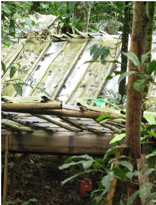
Abbildung 7 Seitenansicht der Dachkonstruktion auf dem Regenwald-Standort
