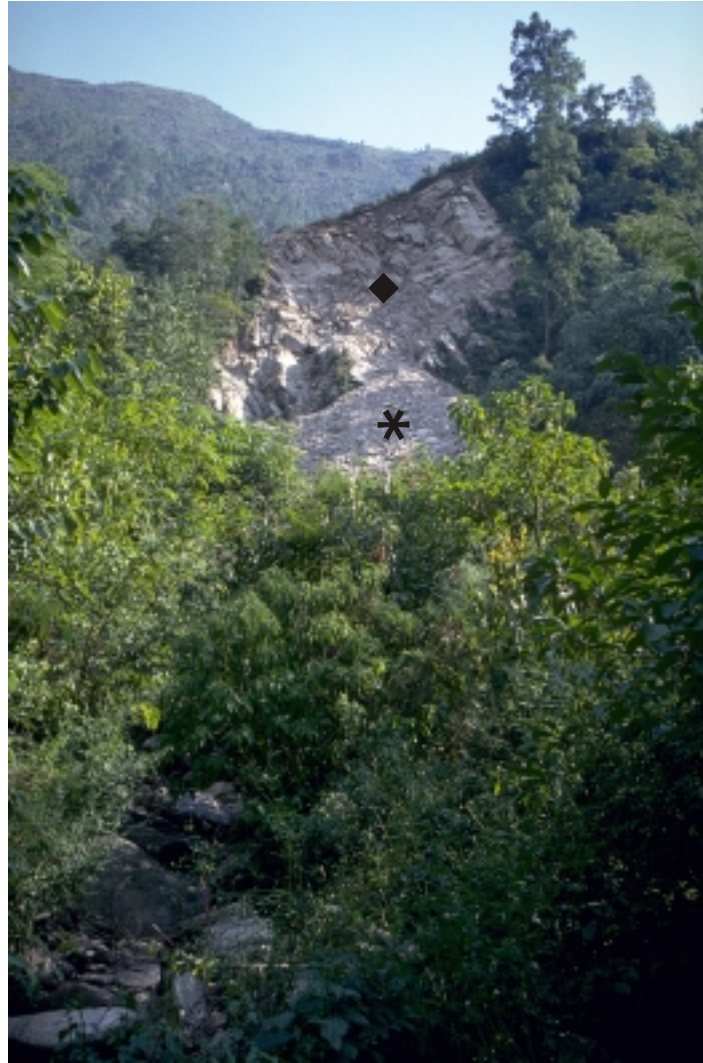
Photo 82: Der Schuttkegel liegt ca. 100m oberhalb der Taltiefenlinie des Bhote Kosi, 800m südlich von Suri Dobhan (1000m). Aufgeschlossen ist das in diesem Talabschnitt anstehende metamorphe Sedimentgestein (◆). Unterhalb der Abruchkante hat sich ein kleiner Schuttkegel (*) gebildet, der sich hinsichtlich der Korngrößenverteilung und Materialzusammensetzung deutlich von den Aufschlüssen differenzieren läßt, die mit Hilfe von Photo 57 , Photo 63 und Photo 83 dokumentiert worden sind. Das Material des im Bild zu erkennenden Schuttkegels entstammt ausschließlich dem Abbruchbereich des lokal Anstehenden. Der Schuttkegel legt sich über erratische Blöcke, die am unteren Bildrand zu erkennen sind.
