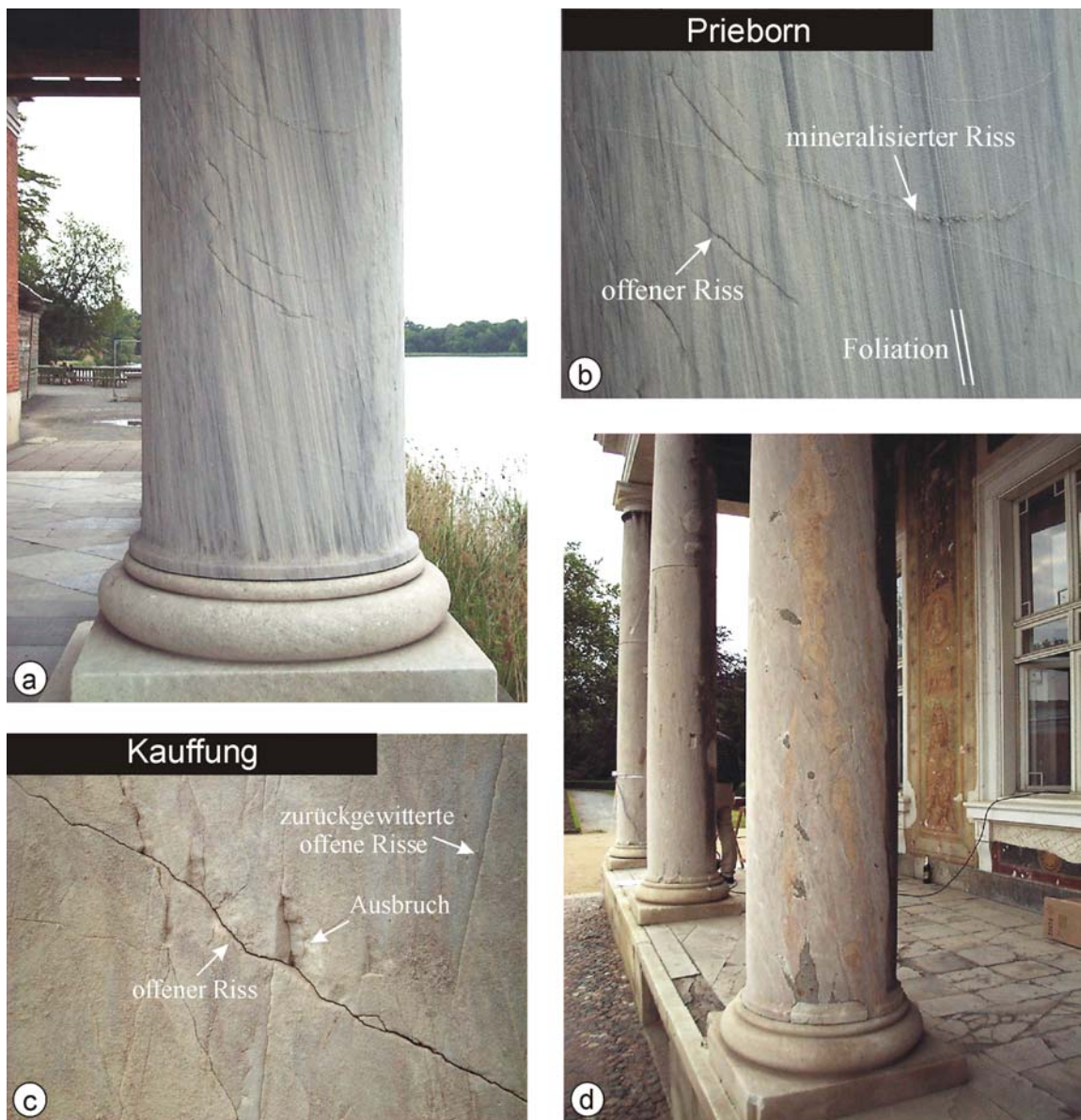
Abb. 8.3: a) Unterer Teil einer Säule aus Prieborner Marmor mit unterlagerndem Säulenprofil aus Grosskunuzendorfer Marmor als statische Bauelemente des zum See ausgerichteten Balkons (Säulendurchmesser 55 cm). b) Detailansicht der Prieborner Marmorsäule zeigt eine deutliche Reliefbildung durch heterogene Rückwitterung des Lagenbaus und verschiedene offene und hervortretende mineralisierte Risse. c) Detailansicht einer Kauffunger Marmorsäule mit verschiedenen Rissen und Ausbrüchen. d) Kauffunger Marmorsäule des nördlichen Seitenflügels mit gelblichen, das Bauteil senkrecht durchziehenden Dolomitadern und zahlreiche mittels Mörtel verschlossene Ausbrüche (Säulendurchmesser 55 cm).
