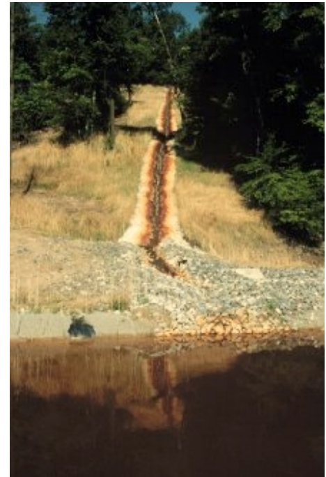
Abb. 1.6.: Regeneration von Minenwässern durch Kalksteinbetten (Quelle: http://www.wvu.edu/~agexten/landrec/passtr/passtr.htm , Stand 09.01.2001).
