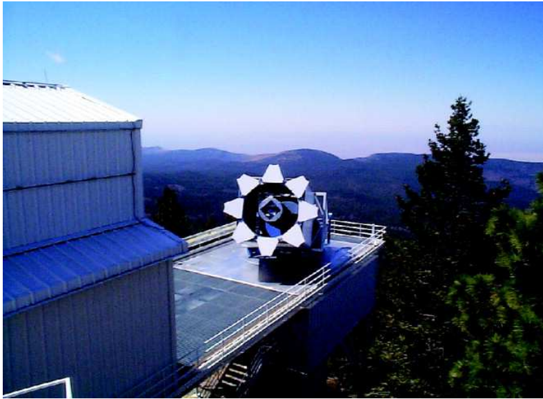
Abbildung 1.5: Das 2.5 m SDSS Teleskop am APO in 2800 m Höhe. Auf der linken Seite ist die fahrbare Teleskopabdeckung zu sehen, die bei Bedarf über das Teleskop geschoben wird, um es vor Witterungseinflüssen zu schützen (Gunn et al., 2006).
