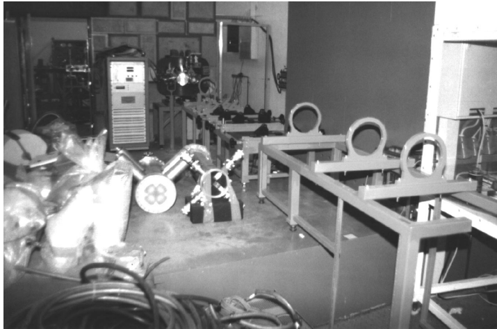
Abbildung 83: Die Strahlrohrteile des Nullgrad-Strahlrohrs, an dessen Ende später die Low-Level NRA-Messapparatur aufgebaut wurde, liegen noch verpackt im Magnetjoch des ehemaligen Zyklotrons.
