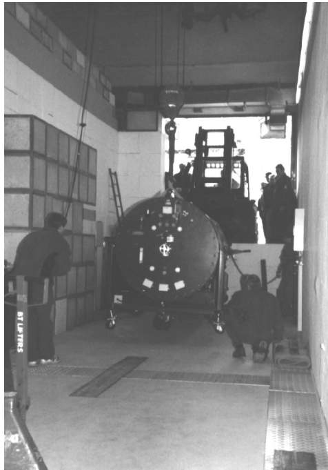
Abbildung 81: Am Schwerlast-Kran hängend wird der Beschleunigertank vom Autor in seine endgültige Position gebracht.
