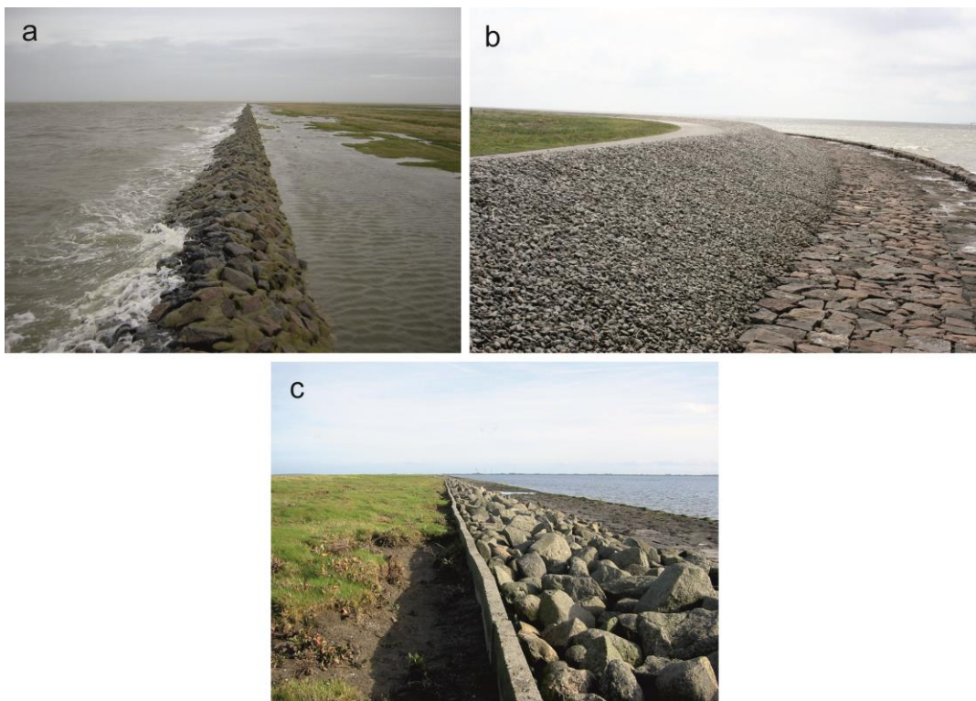
Abbildung 2-3: (a) Konservativer wasserdurchlässiger Raustreifen (Hallig-Igel) auf Nordstrandischmoor. Foto: Schindler 2011. (b) Moderner wasserdurchlässiger Raustreifen (Hallig-Igel) auf Langeneß. Schotter wird mittels eines Zwei-Komponenten-Klebers (Elastocoast®, BASF) zu einem Raustreifen modelliert. Dem Streifen vorgelagert ist ein wasserundurchlässiges Pflaster aus Basaltblöcken. Foto: Deicke 2014. (c) Alter Raustreifen auf Nordstrandischmoor. Das Niveau der binnenseitigen Salzmarsch wächst über die Höhe des Raustreifens hinaus. Foto: Schindler 2012.
