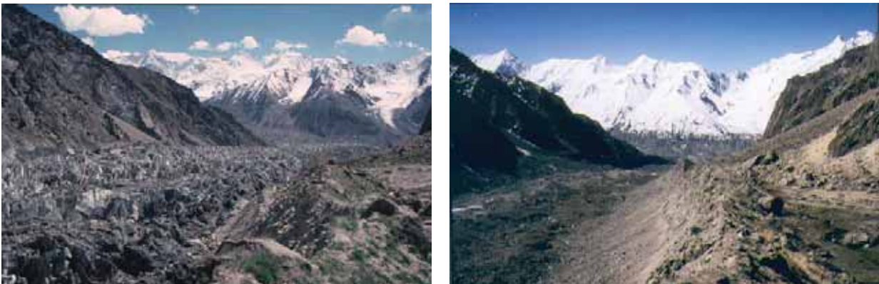
Photo 4.2.1.8.3: Blick aus 4200 m während des 1989-Hochstandes von der rechten Ufermoräne des Pumari Chhish-Gletschers talabwärts in Richtung Süden. Es erfolgten im Oberlauf keine Überschüttungen der Ufermoräne in das Eisrandtal. Aufnahme: M. Searle, Sommer 1989.
