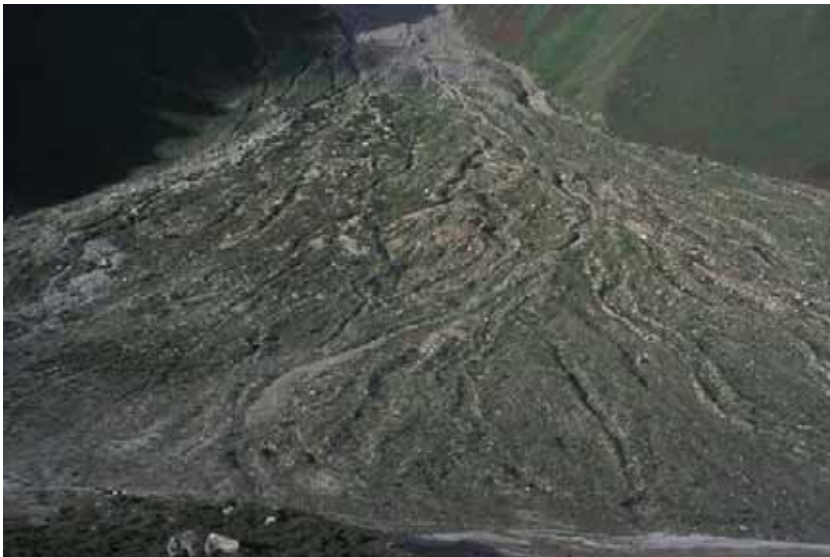
Photo 4.3.1.10: Aufnahme von der rechten Ufermoräne bei Arencho auf den aktiven Murkegel, der in das Eisrandtal dräniert. Aufnahme: L. Iturrizaga 16.07.2001.
