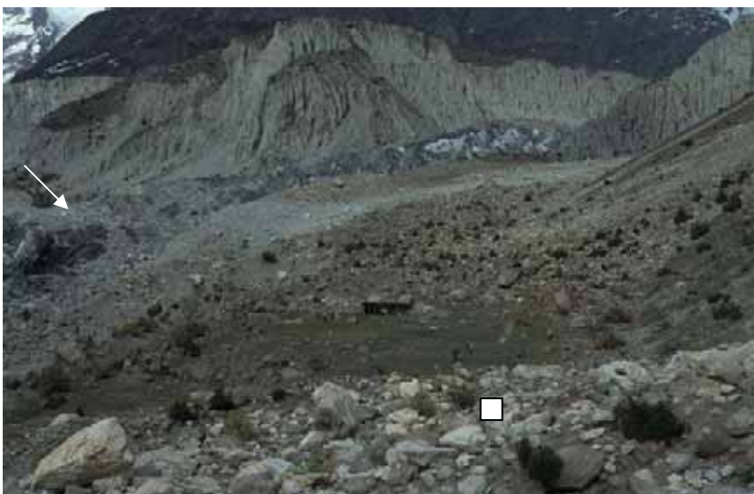
Photo 4.1.3.5: Blick von den bereits stark degradierten Eisrandterrassen (□) auf die Konfluenz von Shispar- und Mutchual-Gletscher (↘). An den steilen Talflanken haften weiter talabwärts zerrunste Moränenschleier. Aufnahme: L. Iturrizaga 22.09.1992/ 637.
