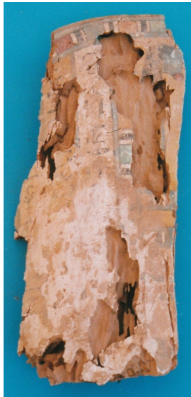
b) Außensargdeckel der Taj: starke Zerstörung im Bereich des Fußes. Foto: Elke Mähltitz-Galler.
