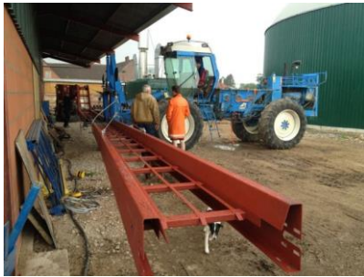
Abbildung 101: Erntemaschinenprototyp - Bau Förderbandrahmen
