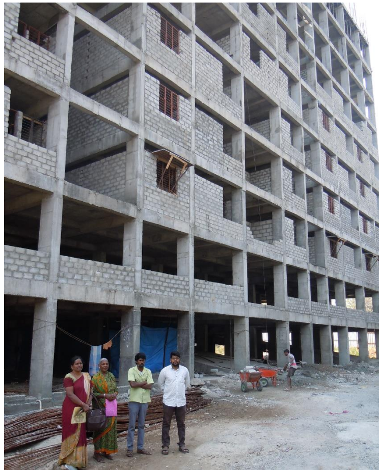
Abbildung 9: Wohnblock für Slumbewohner nach dem 2BHK-Scheme im Rohbau
