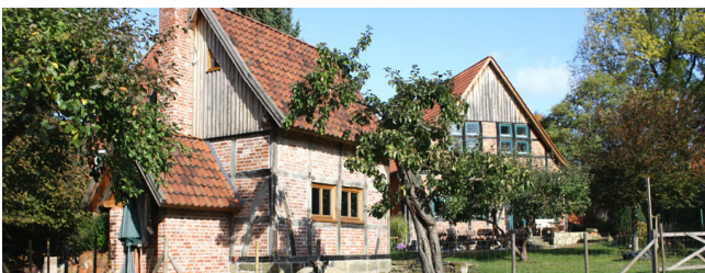
Abbildung 2: Bild mit historisch aussehendem Gebäude auf Erstansicht
