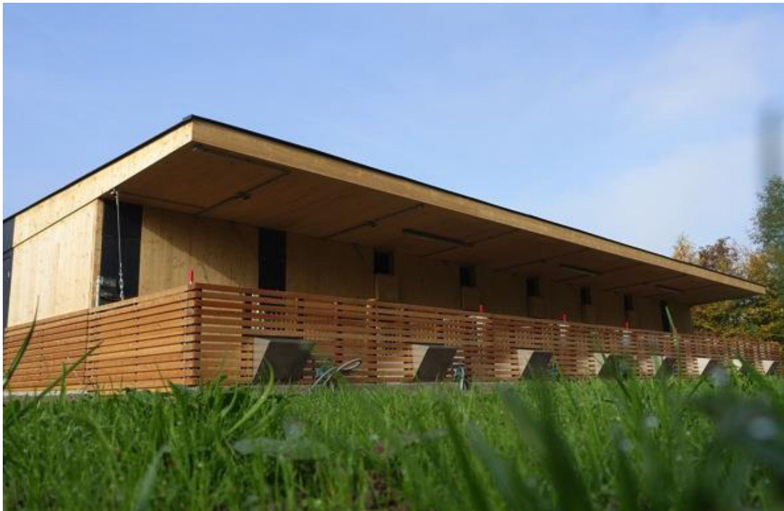
Abbildung 2: Massivholz-Schweinestall der Versuchsstation Raumberg-Gumpenstein (Österreich)
