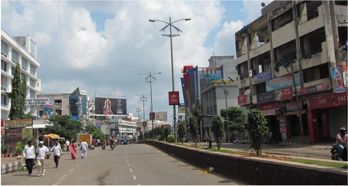
Abbildung 36: Begrünung, Beleuchtung und neue Fahrbahn nach der Straßenerweiterung
