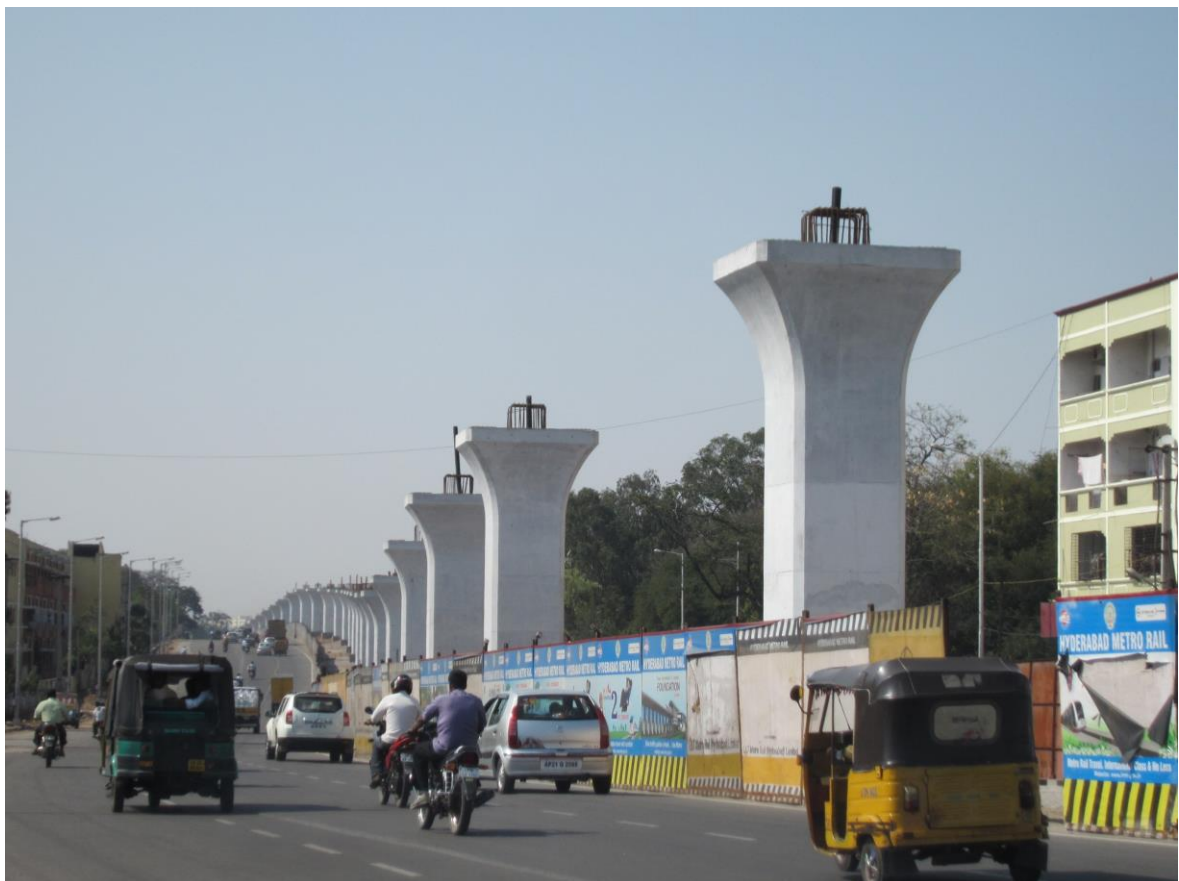
Abbildung 8: Bau der gestelzten Hochbahn in Hyderabad
