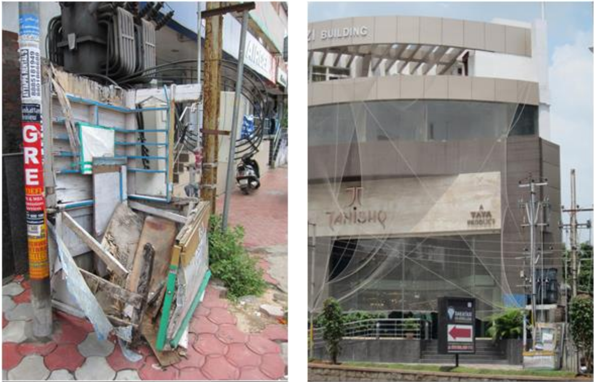
Abbildung 37: Zerstörtes Paan-Geschäft (links) vor Juweliergeschäft (im rechten Bild unten rechts)
