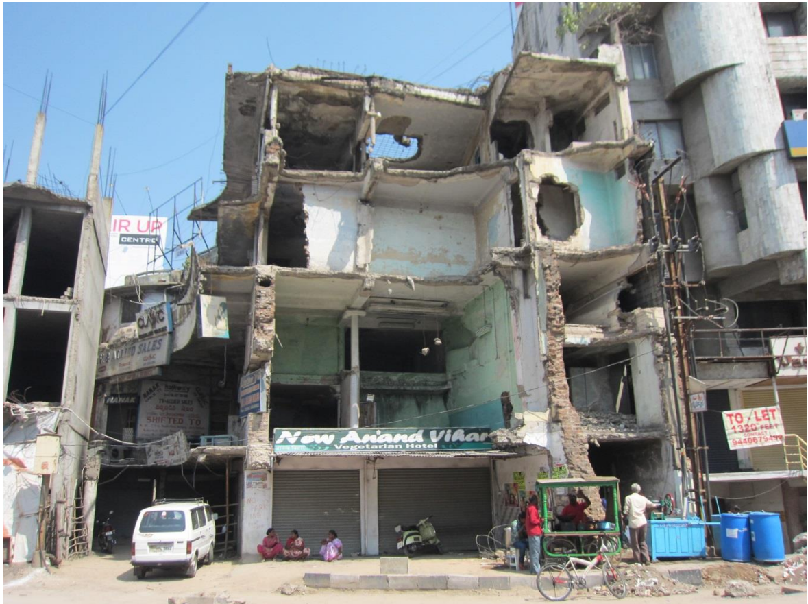
Abbildung 35: Gebäude an der Himayath Nagar Road mit entfernter Fassade
