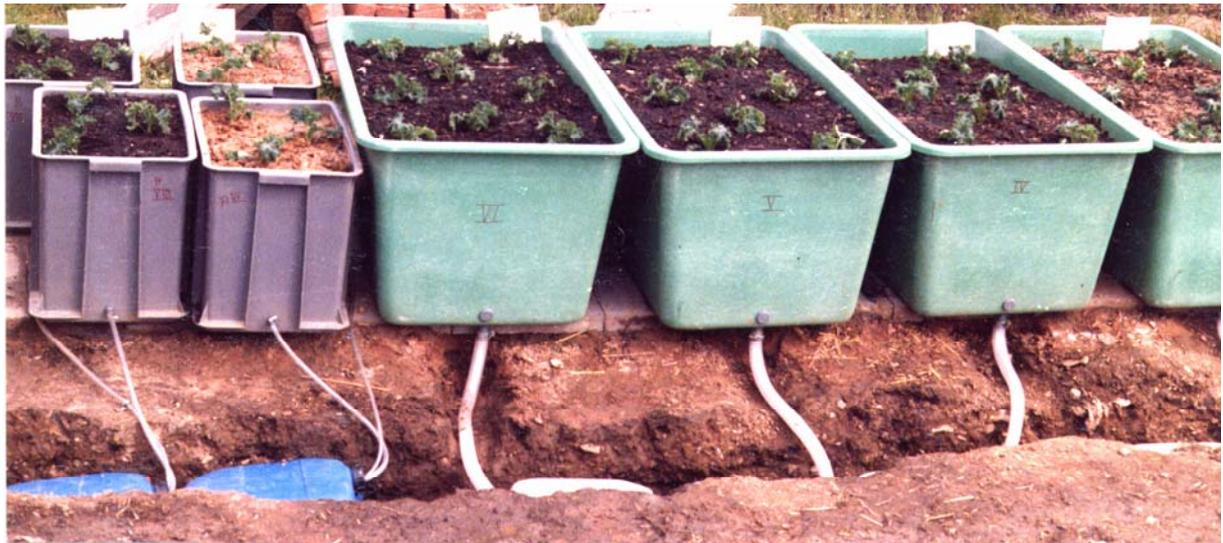
**Abbildung 1: Bau der Lysimeter-Anlage (von rechts nach links: Lysimeter 3 – 6, 7 a und b, 8 a und b), Aufnahme vom 27.05.87 von B. BANSE**
