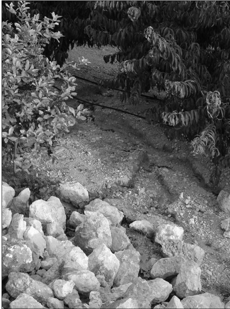
Foto 15: Erosionsrinnen auf einer Hangterrasse in der Nähe von Ğnien Busewdien nach dem Unwetter im Oktober 2003. Im Vordergrund eingestürzte Rubble Wall. Foto: ASCHEMEIER
