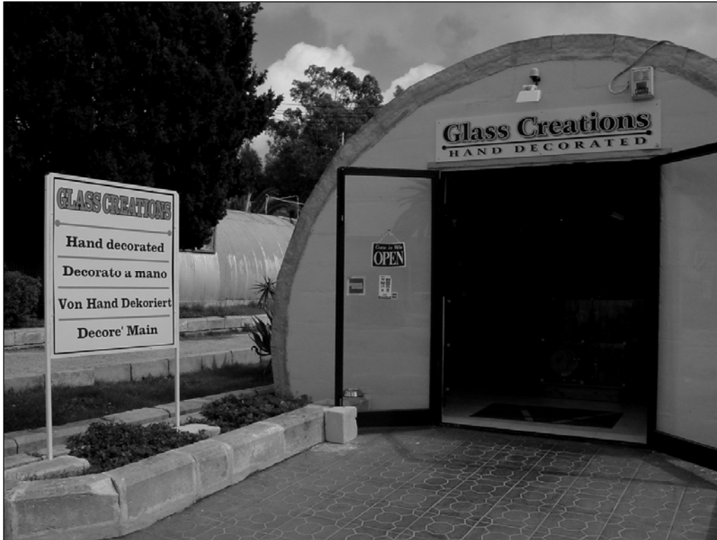
Foto 28: Die typische Bauweise der Shops und Werkstätten in Ta'Qali. Genutzt werden gegenwärtig vor allem alte Wellblech- und Kalksteinbaracken die von den britischen Luftstreitkräften zurückgelassen wurden. Foto: ASchemeier
