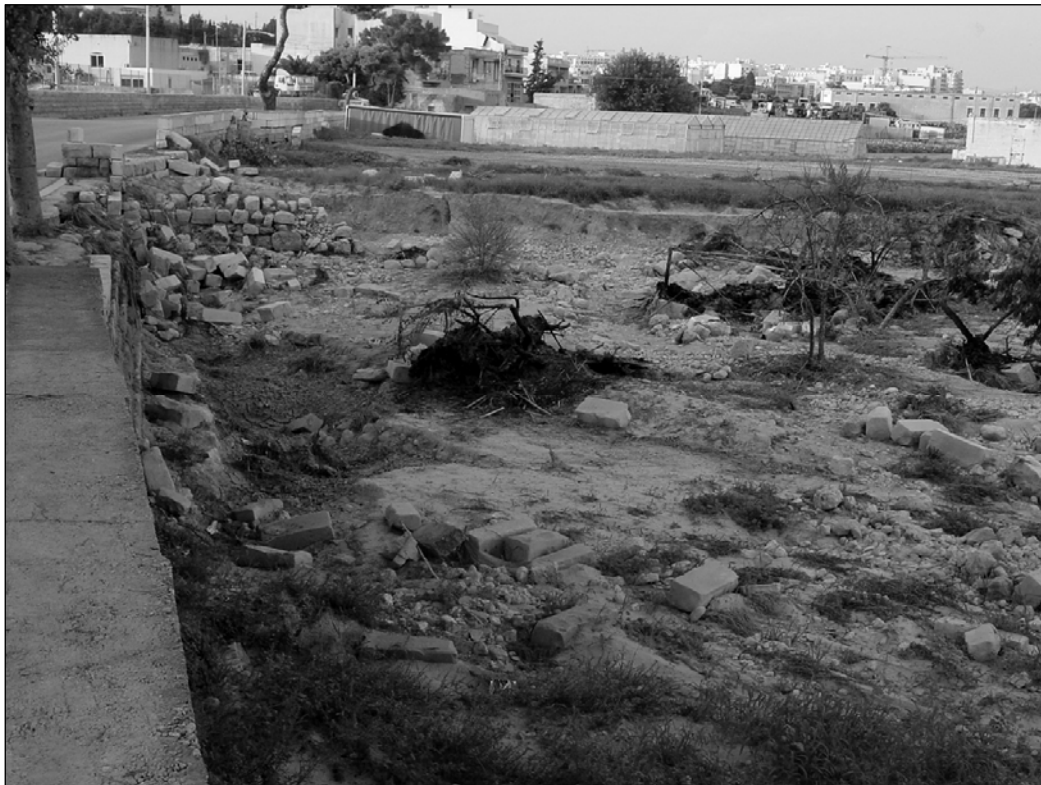
Foto 14: Schäden des Unwetters vom Oktober 2003 am Rand der Ortschaft Burmarrad. Selbst mit Mörtel gefugte Straßenbegrenzungsmauern wurden weggespült. Dahinter eine vernichtete Obstbaumanpflanzung. Der Landwirt hat die Überreste seiner vom Wasser entwurzelter Bäume abgebrannt. Foto: ASCHEMEIER
