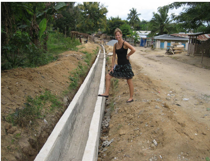
Abb. 18: Bau einer Abwasserrinne in Assin Foso (eigenes Foto, 2009)
