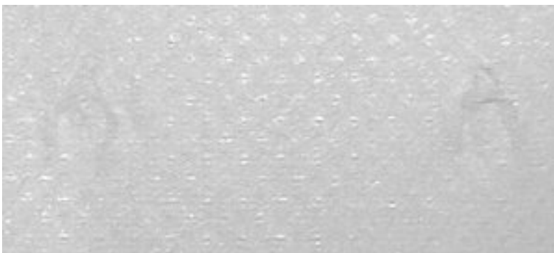
Abb. 27: Deckenunterseite TC 1050 mit kleinen gestanzten sowie größeren runden Luftaustrittslöchern
