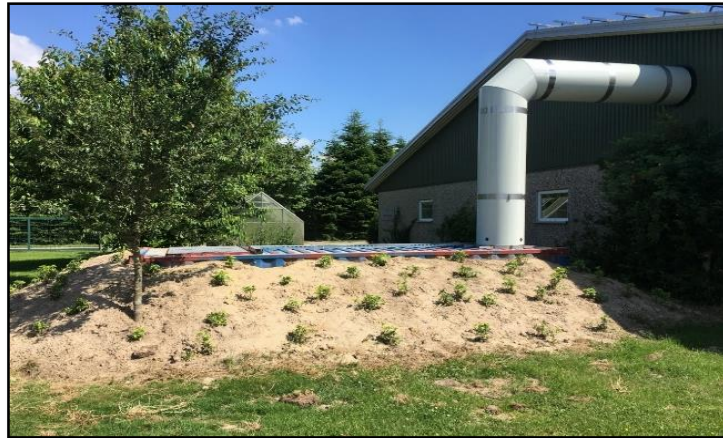
Abbildung 8: Außenansicht des Moduls nach dem Einbau im Erdreich am Standort Vechta.
