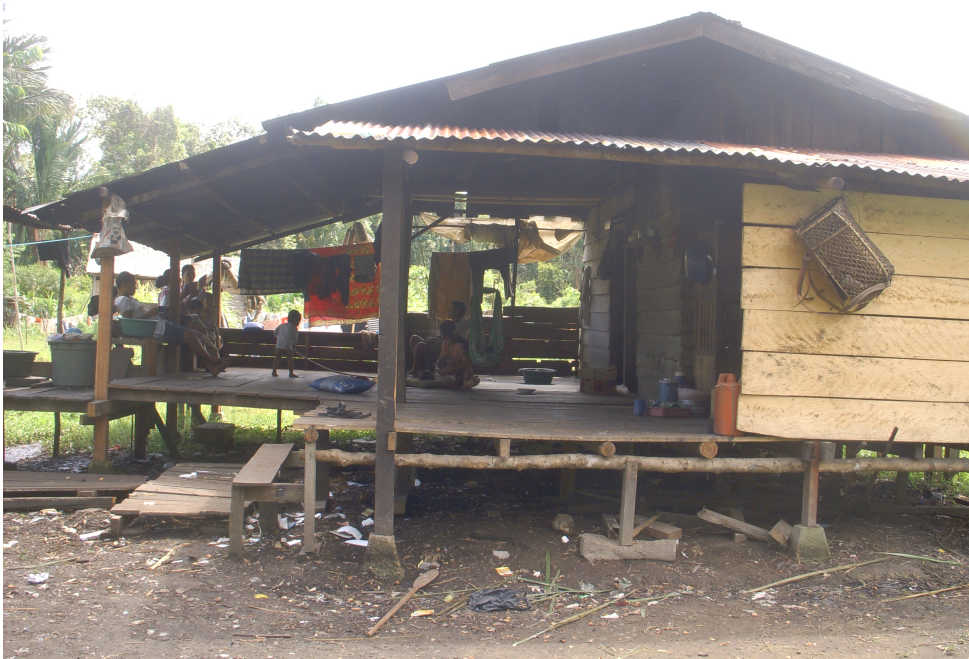
Abb. 5: Ein typisches Haus in Policoman (Foto von Debi F. Simanjuntak)
