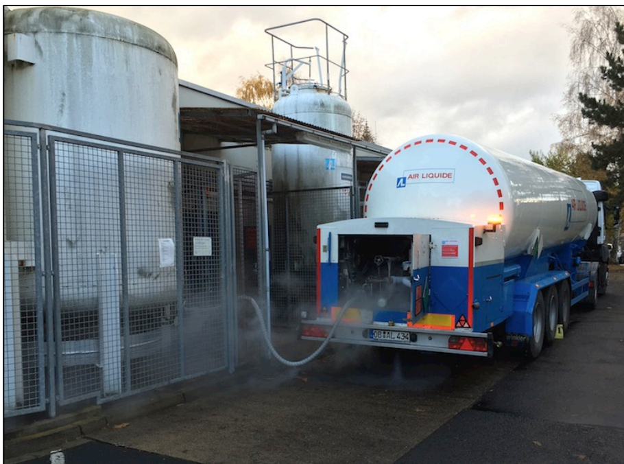
Abbildung 8: Anlieferung Sauerstoff durch Firma Air Liquide (Quelle: Eigene Aufnahme)
